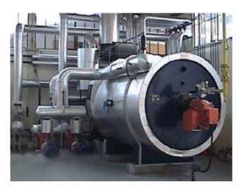
الأنظمة التي تستخدم زيوت نقل الحرارة مع درجات حرارة غليان تتراوح بين 260 درجة منوية و 390 درجة منوية تسمى أنظمة الزيت الساخن. يُفضل في المناطق التي تتطلب درجات حرارة تشغيل عالية مثل الصناعة الكيميائية والتجفيف والطهي.
